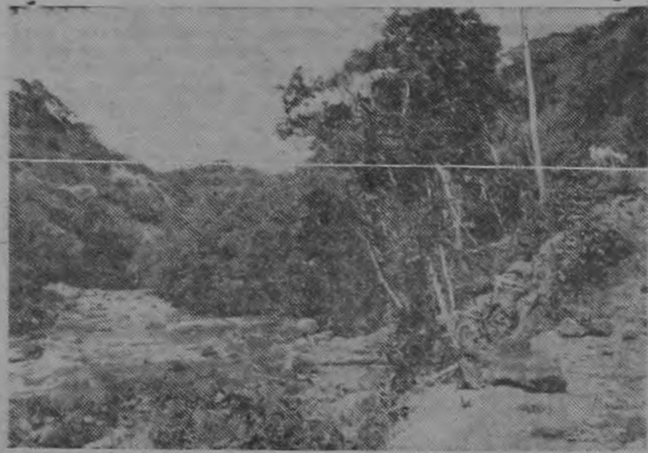
El Bajo de La Garita lugar en el Río Grande en el cual se levantará la presa que abastecerá de agua a las turbinas que generarán 30.000 kilowatts con un costo total de 60 millones de colones.— La línea imaginaria trazada arriba señala la altura de la presa. (Foto Arévalo)
